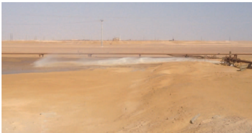
Рис. 9. Процесс обработки нагнетательной скважины № 115 с помощью ГИУ (24.04.2014) на месторождении Saih Rawl – Petroleum Development Oman (PDO). Истечение жидкости при открытой задвижке
