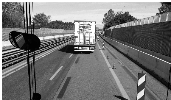
Рис. 1. Участок автомагистрали с шумозащитными барьерами вдоль обеих ее сторон
